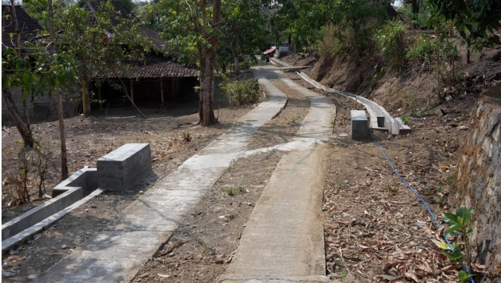
Het aangelegde irrigatie kanaal in Lembu
